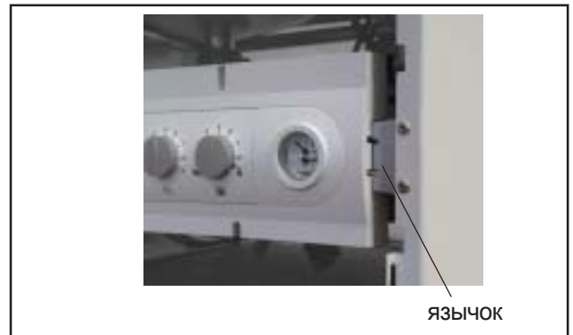
рис.: Нажать на язычок зажима
